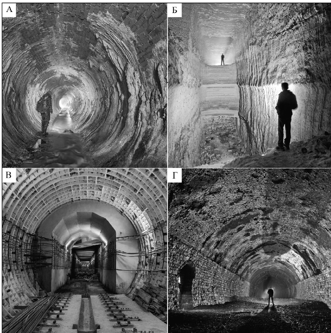
Рис. 1. Подземные сооружения как формы субрельефа: А – коллектор подземной реки; Б – известняковая шахта; В – строящийся тоннель метро; Г – заброшенный железнодорожный тоннель. Фотографии В.А. Неходцева
