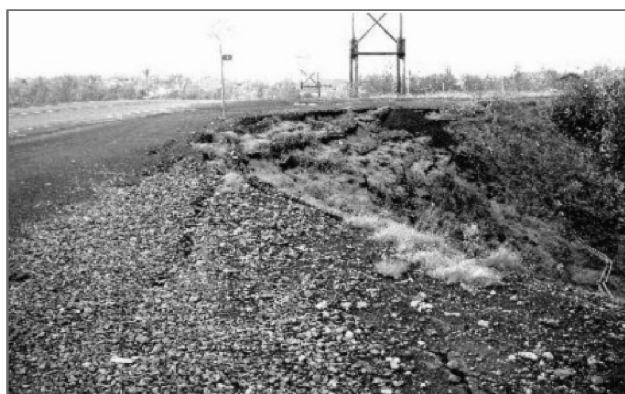
Рис. 1. Деформации дорожных насыпей в криолитозоне: слева — оседание насыпи автодороги Норильск — Талнах (построена в 1960-х гг., фото в сентябре 2010 г.), справа — волнообразные деформации на автодороге «Амур» (строительство закончено в 2010 г, фото в августе 2013 г., предоставлено С.А. Пищуловым)
