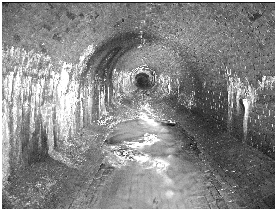
Рис. 1. Участок коллектора р. Неглинной с размытым дном. Фото В.А. Неходцева
