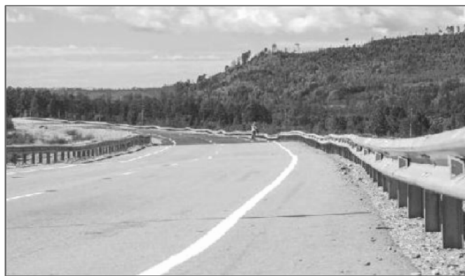
Рис. 1. Деформации дорожных насыпей в криолитозоне: слева — оседание насыпи автодороги Норильск — Талнах (построена в 1960-х гг., фото в сентябре 2010 г.), справа — волнообразные деформации на автодороге “Амур” (строительство закончено в 2010 г, фото в августе 2013 г., предоставлено С.А. Пищуловым)
